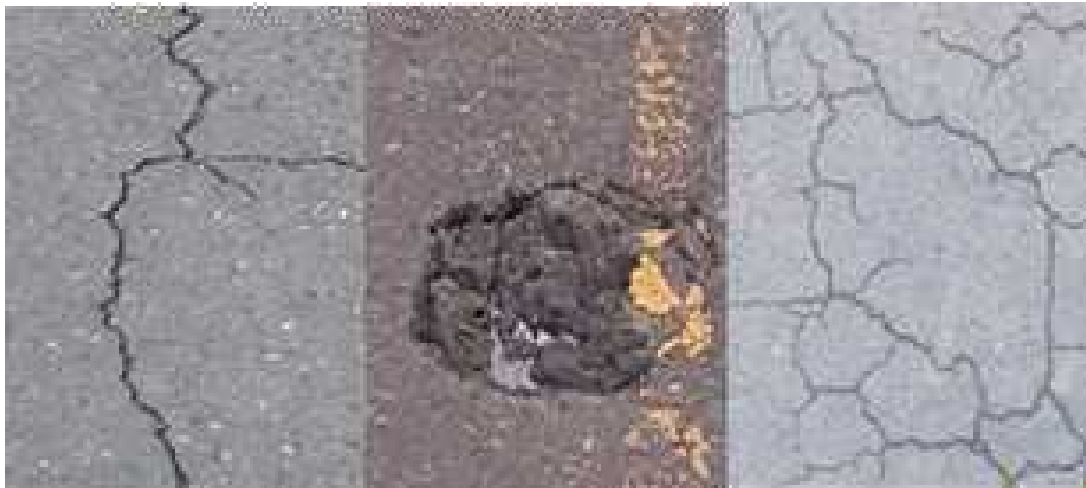
Figura 14.1: Contexto general del problema abordado por IDIRPA. A partir de imágenes de pavimento, el sistema identifica y cuantifica irregularidades como grietas, baches y piel de cocodrilo, con fines de inspección y apoyo a mantenimiento vial.
